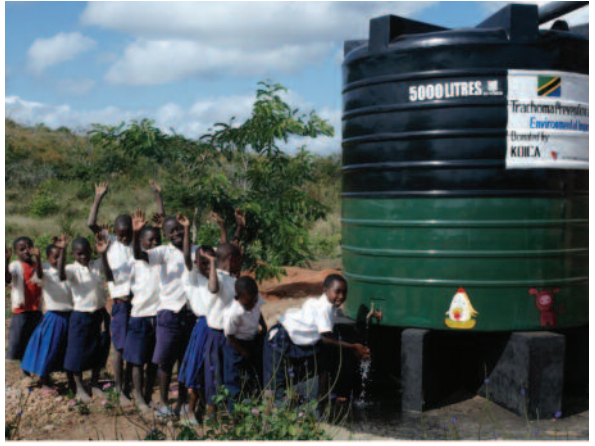
초등학교 물탱크 설치
